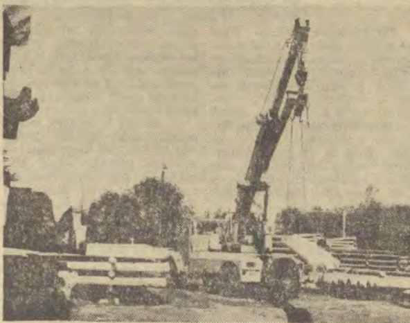
A Faanyagvédelmi és Fatelítő Vállalat dombóvári üzemében autódaru segítségével mozgatják a rönköket, oszlopokat és talpfákat.
